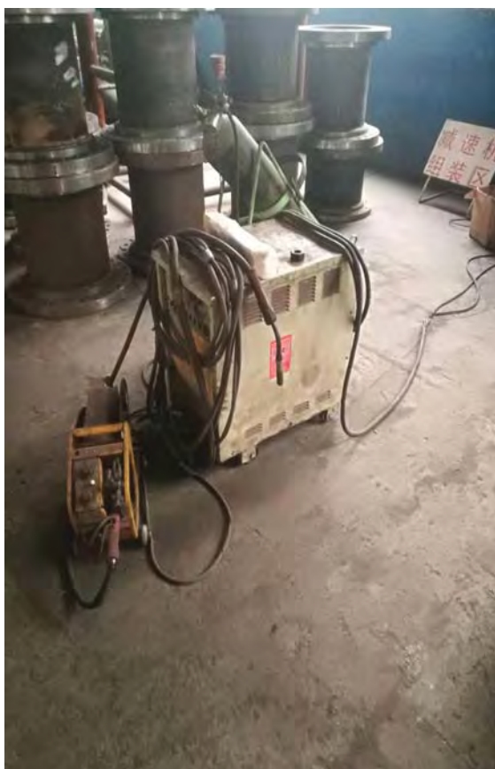
图 2-18 抽油机支架、游梁、底盘、驴头工艺的焊接
